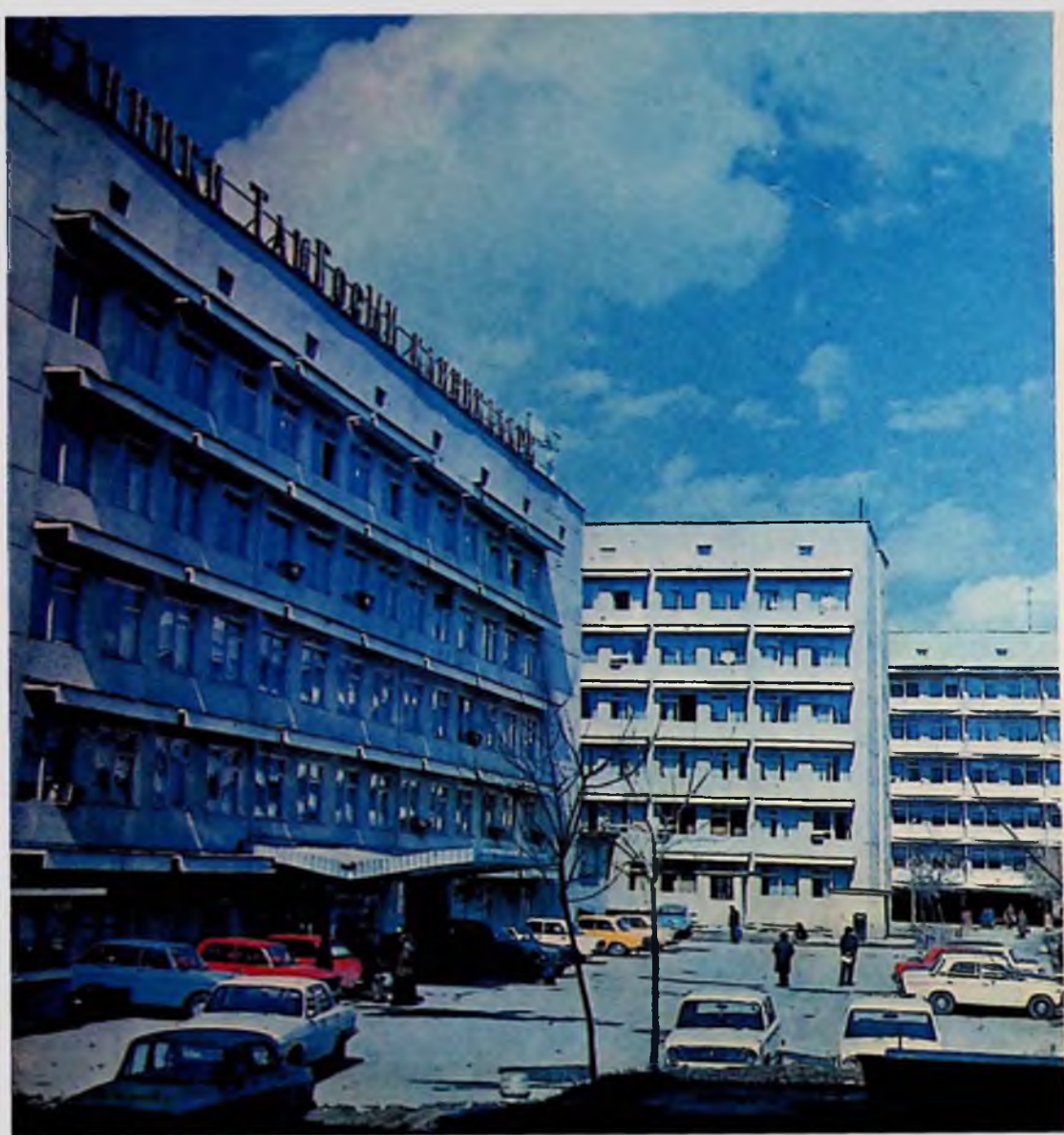
Фасад главного здания клиник ТашГосМИ.
